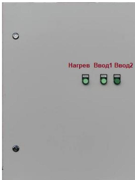
Рисунок 1.4 - Расположение световых индикаторов
