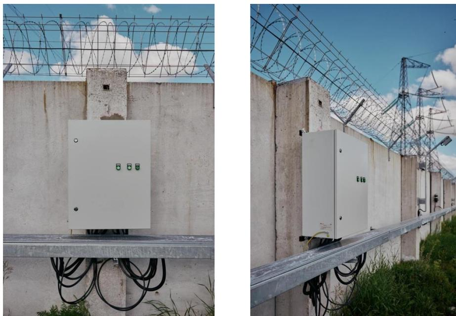
Рисунок 2.1 - Пример установки шкафа на ж/б забор
